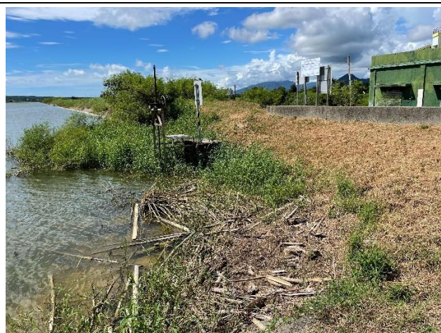
說明：堤岸邊坡植生情形
