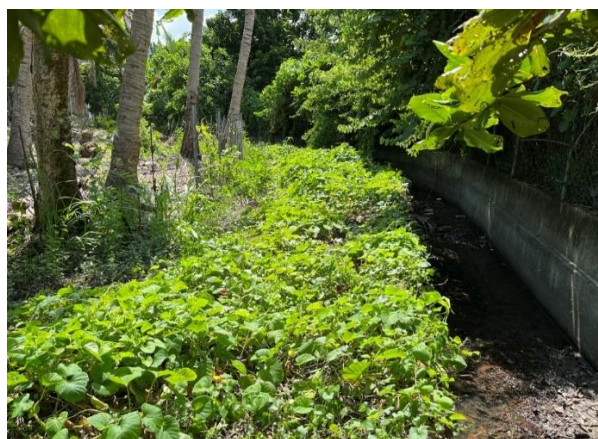
說明：2+843~2+871 砌石工渠道，中圳埤幹線一分線等現況
