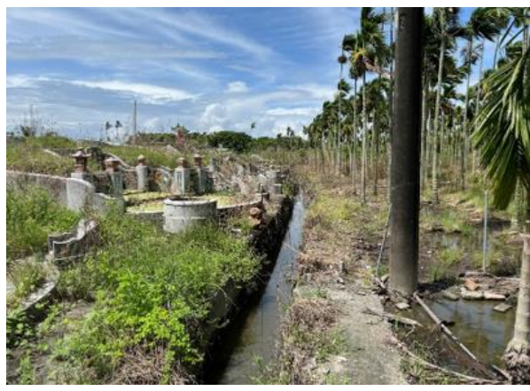
說明：0+180~0+250 砌石工渠道，，中圳埤幹線一分線等現況
