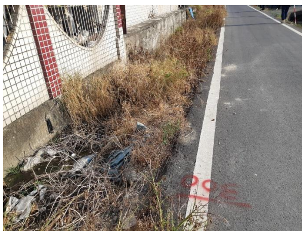
說明：0+300 內面工渠道，永安圳小排 14-11 等現況
