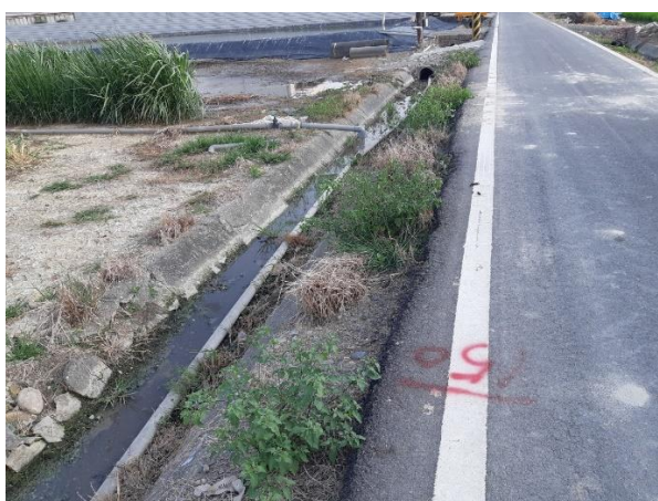
說明：0+150 內面工渠道，永安圳小排 14-11 等現況
