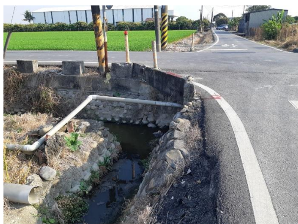
說明：0+000 砌石工渠道，永安圳小排 14-11 等現況
