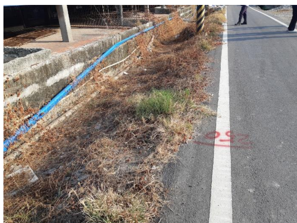
說明：0+250 內面工渠道，永安圳小排 14-11 等現況
