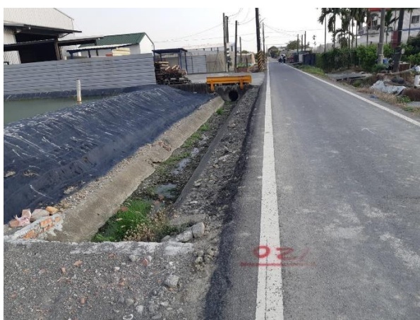
說明：0+100 內面工渠道，永安圳小排 14-11 等現況
