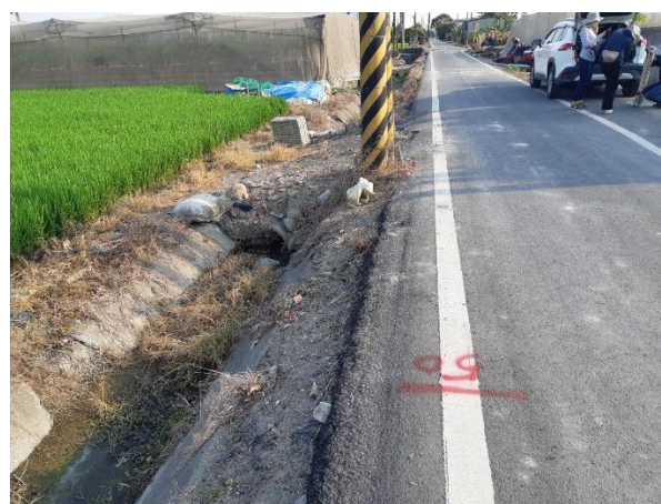
說明：0+050 內面工渠道，永安圳小排 14-11 等現況
