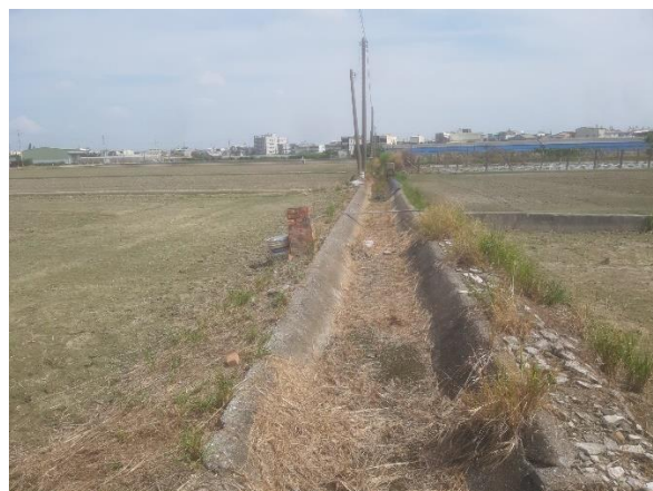
說明：0+250 內面工渠道，萬丹圳第四支線小給二之五等現況
