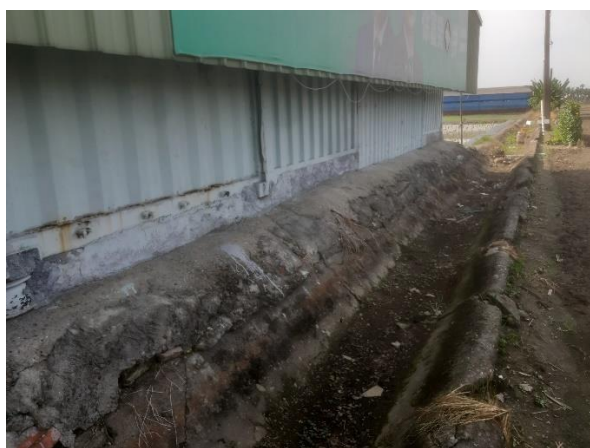
說明：0+000 內面工渠道，萬丹圳第四支線小給二之五等現況
