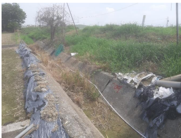
說明：0+400 內面工渠道，萬丹圳第四支線小給二之五等現況
