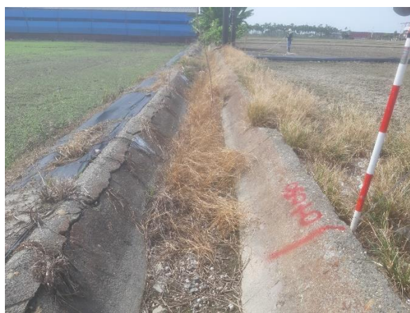
說明：0+050 內面工渠道，萬丹圳第四支線小給二之五等現況
