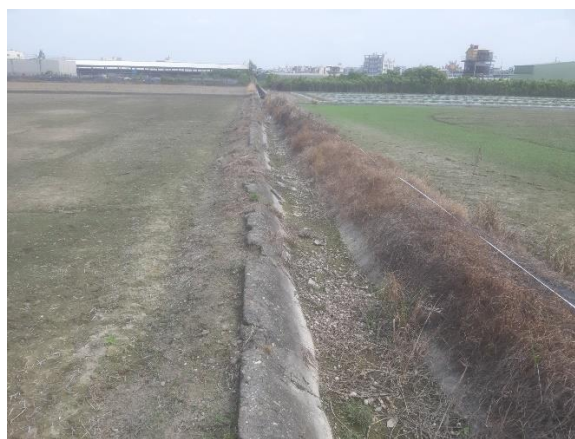
說明：0+600 內面工渠道，萬丹圳第四支線小給二之五等現況
