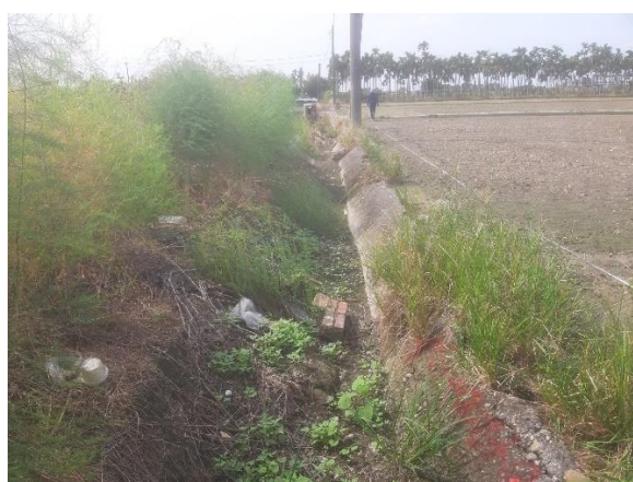
說明：0+150 內面工渠道，萬丹圳第四支線小給二之五等現況
