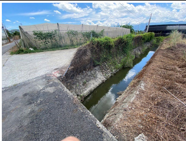
說明：林文埤一分線工區
