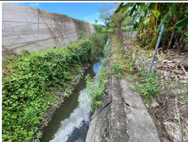
說明：林文埤一分線工區
