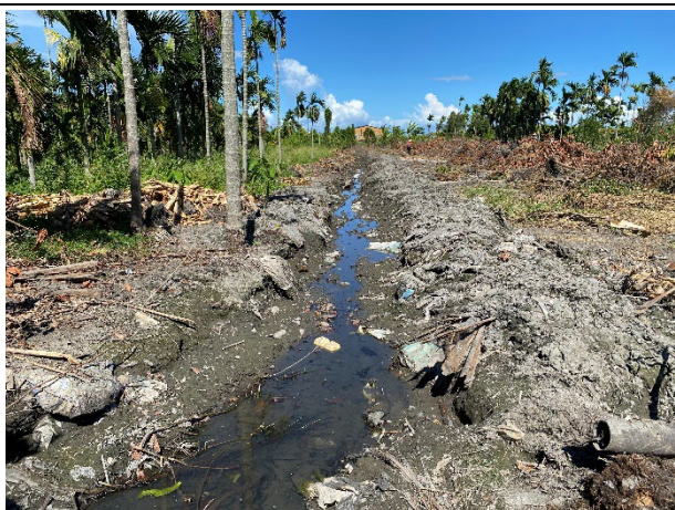
說明：上崙子頂埤三支線工區
