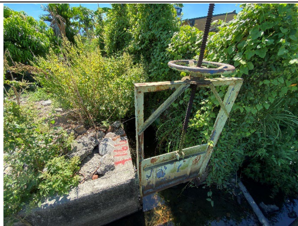
說明：上崙子頂埤三支線工區
