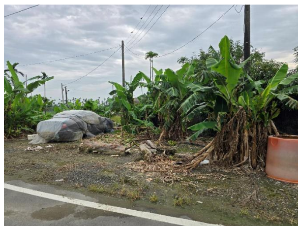
說明：萬丹圳第五支線小給二工程起點
