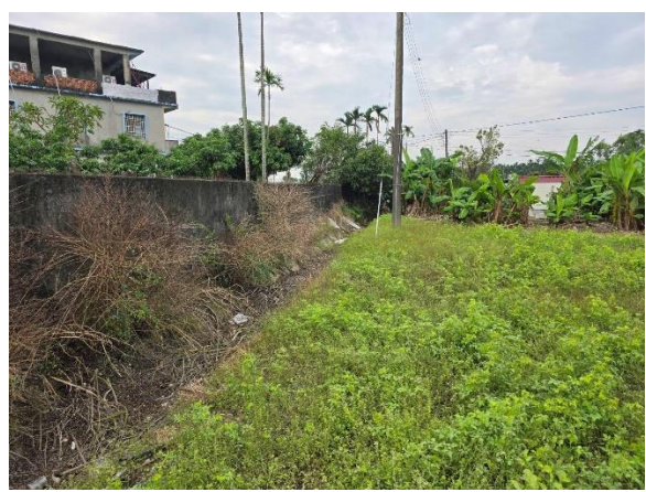
說明：萬丹圳第五支線小給二 圳路中段
