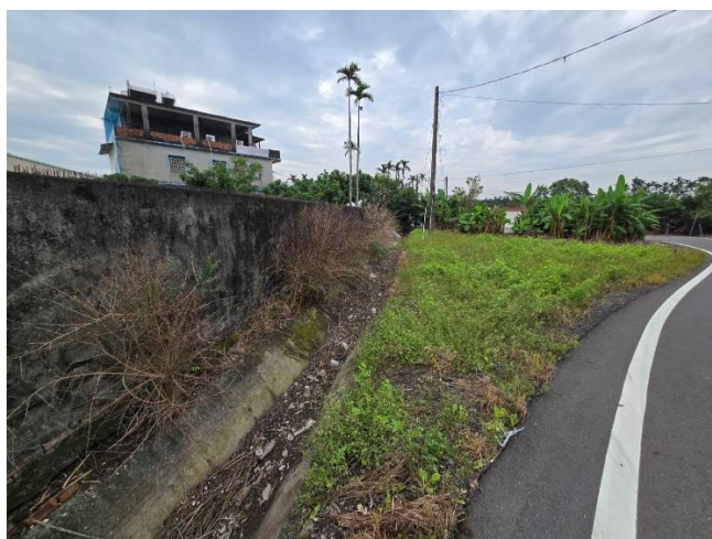
說明：萬丹圳第五支線小給二圳路中段
