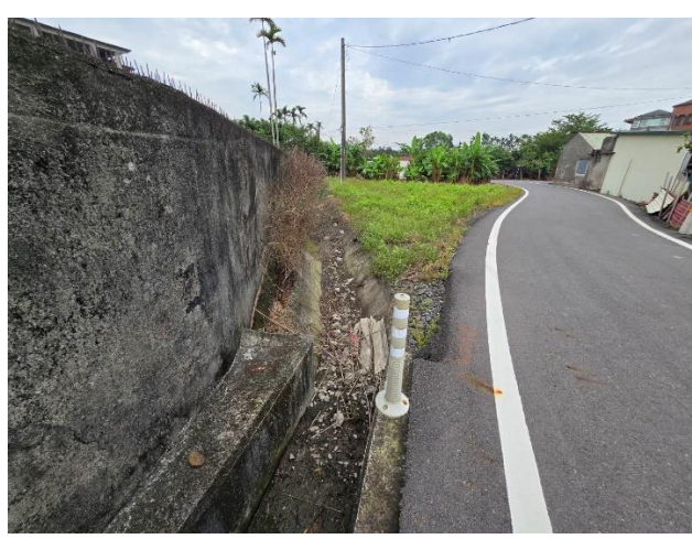
說明：萬丹圳第五支線小給二施工終點
